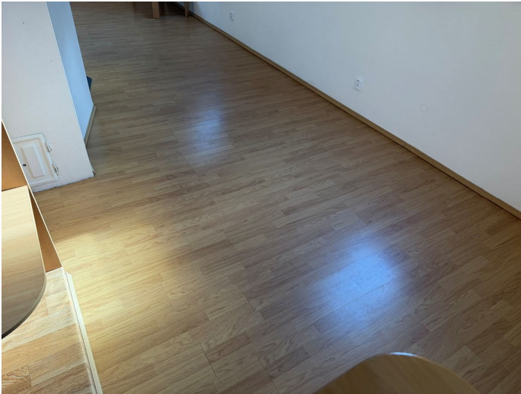
Pohled na podlahy
