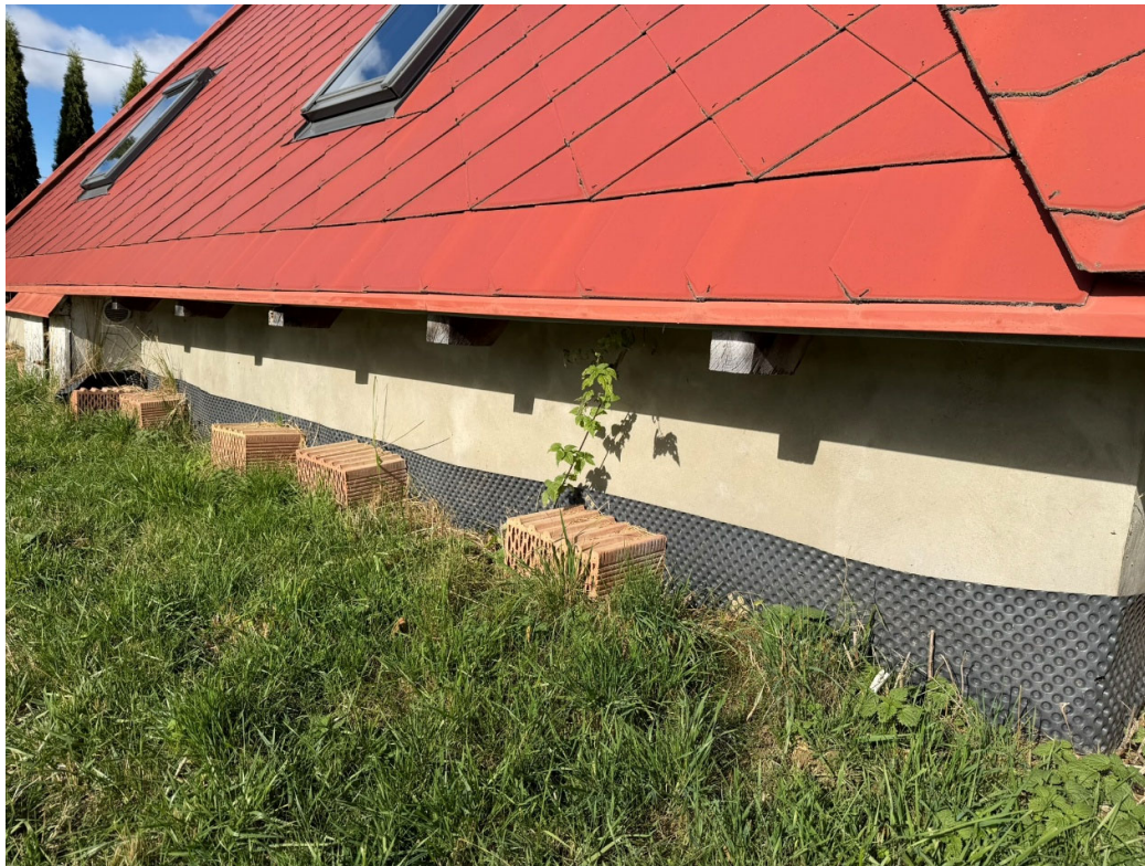
Střešní krytina a dřevěný vnější krov
