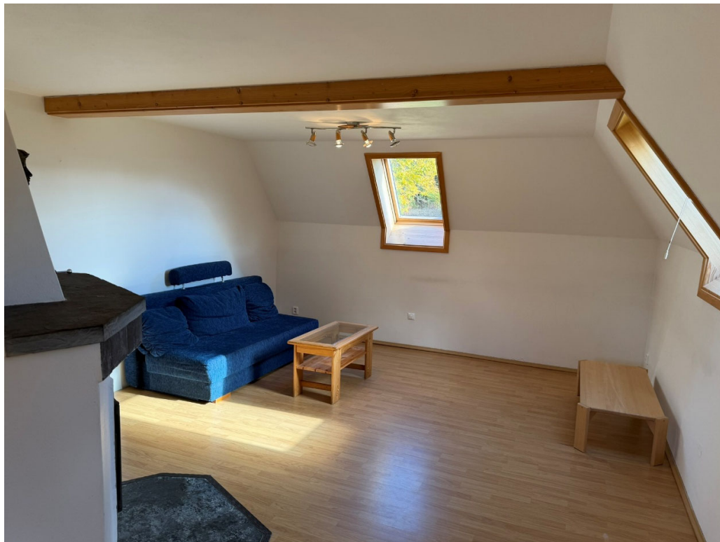
Pohled na podlahy
